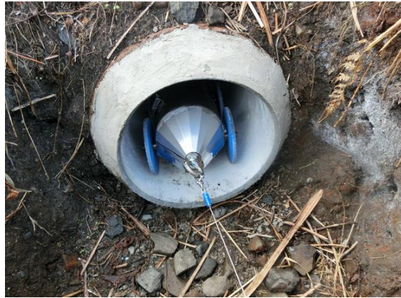
図.5-2 終端位置への各ユニット送り込み
